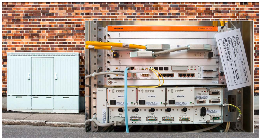
Mit Glasfaser aufgerüsteter Kabelverzweiger: Hier enden die Kupferkabel aus den umliegenden Häusern und erhalten von den eingebauten DSL-Gegenstellen (DSLAMs) ihr VDSL-Signal.
