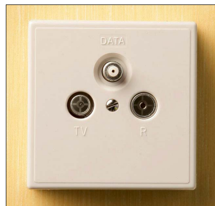
Auf die dritte Buchse kommt es an: Wenn bei Ihnen eine solche „Multimediadosen“ mit „Data“-Anschluss installiert ist, können Sie schnelles Internet via Kabelanschluss bekommen.
